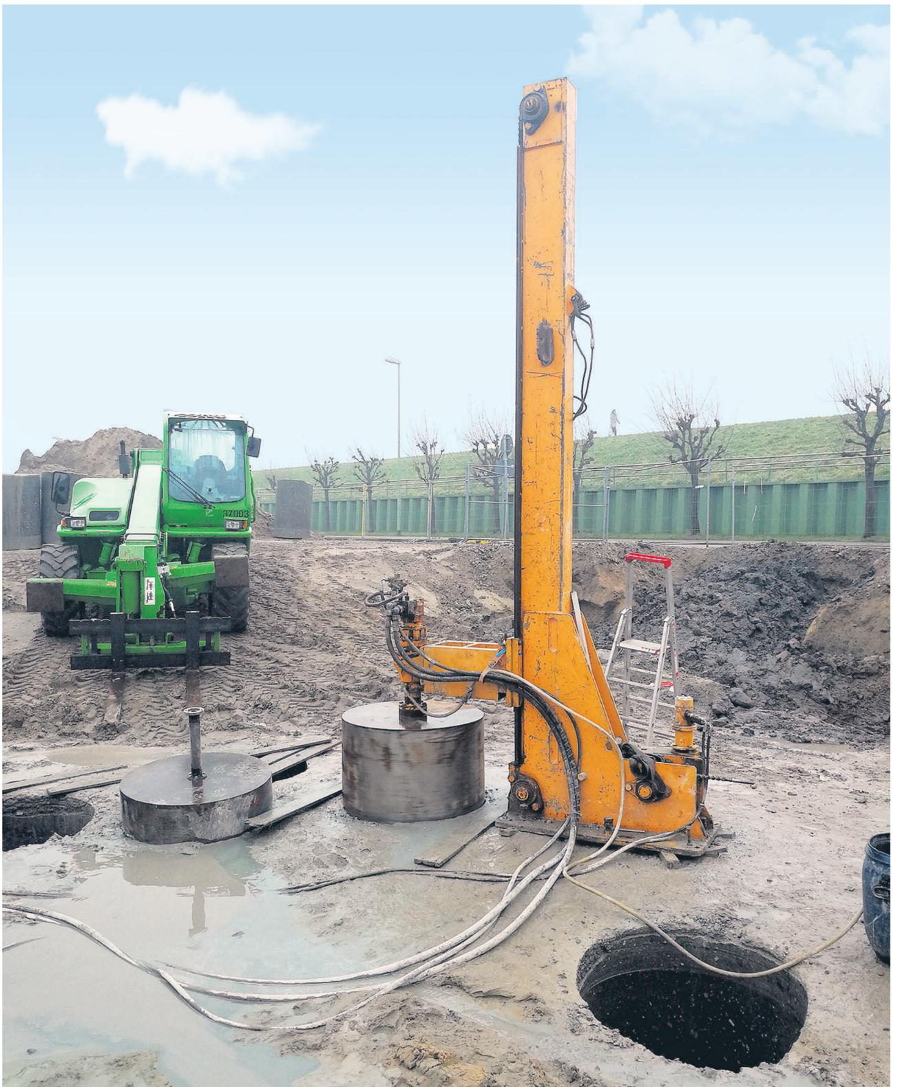
**EINE BESONDERE HERAUSFORDERUNG** meisterte jetzt wieder das Team der A&S Betondemontage GmbH aus Lehrte bei Hannover: Im Rahmen eines Neubauprojekts für Eigentumswohnungen im Neuen Hafen von Bremerhaven sollte in Vorbereitung für den Spezialtiefbau eine alte, bis zu 2 m dicke Bunkersohle durchbohrt werden. Lesen Sie hierzu auch unseren Bericht „Bunkersohle durchbrochen“ auf Seite 8.
